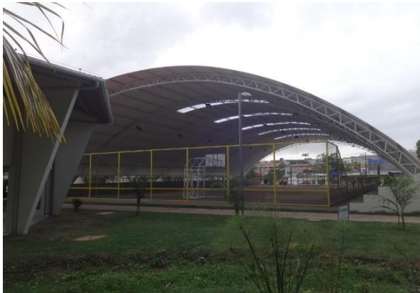
Quadra poliesportiva coberta construída no Parque do Bom Menino. São Luís, 25.11.2020.
