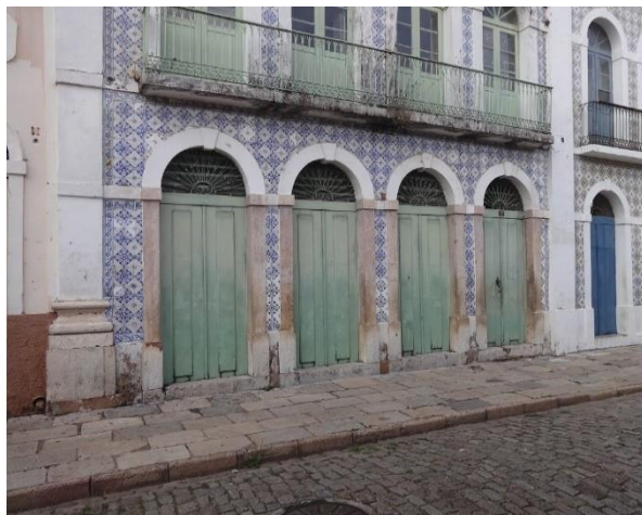
Fachada do prédio da Rua Portugal, nº 251. São Luís, 25.11.2020.
