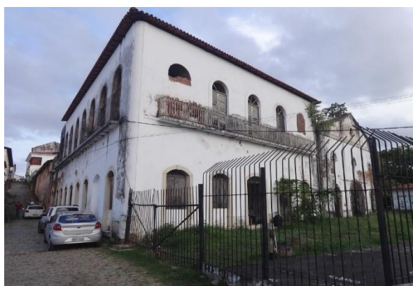
Edificação em uso no Complexo Trapiche de Santo Ângelo. São Luís, 25.11.2020.
