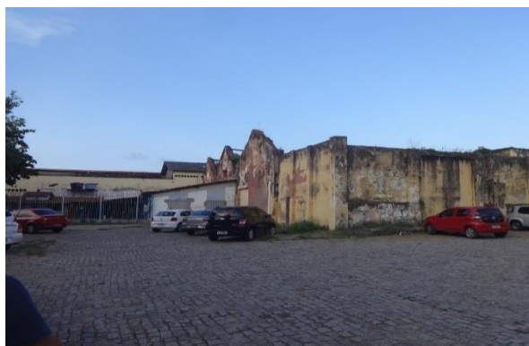
Ruínas de galpões. São Luís, 25.11.2020.
