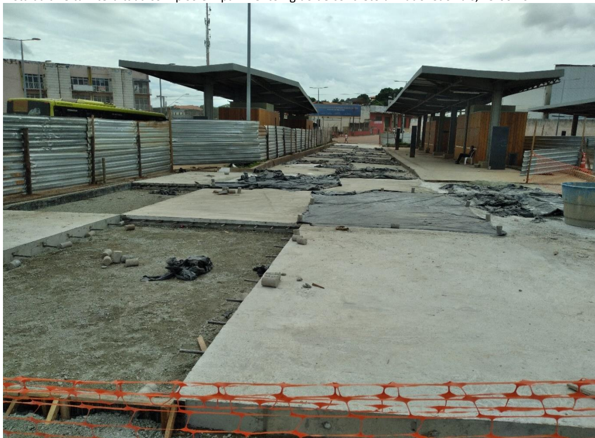
Pista central interditada para execução de piso em pavimento rígido de concreto armado. São Luís, 29.06.2022.
