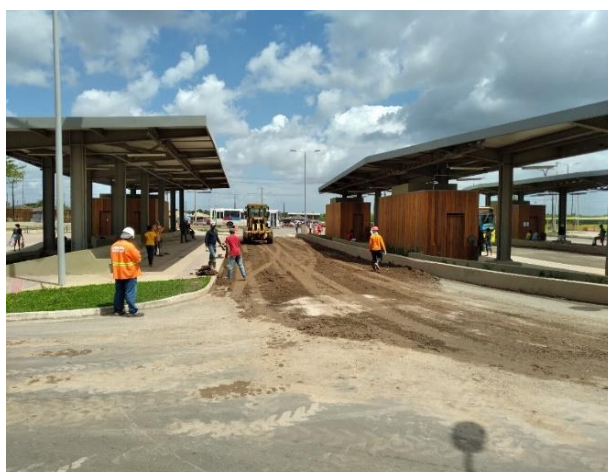
Baia interditada para a recuperação de umas das pistas. São Luís, 10.07.2021.
