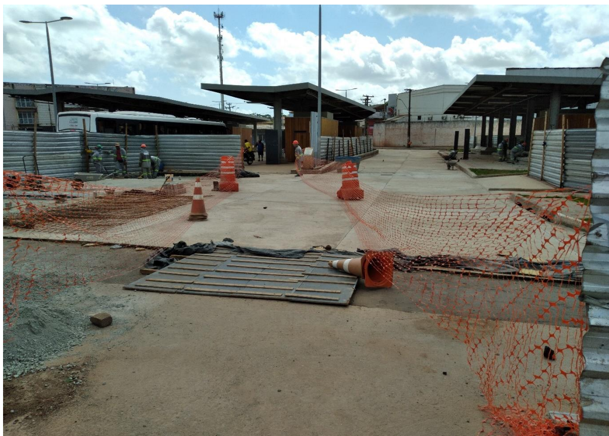
Figura 63 – Obra em uma das pistas do Terminal Rodoviário
