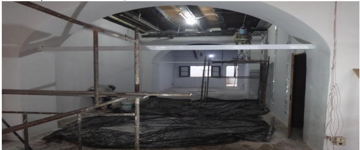
Interior ainda sendo reformado. São Luís, 25.11.2020.
