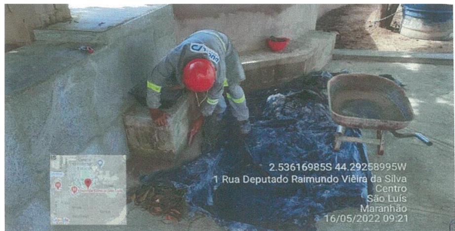
Figura 1: Revestimento dos canteiros e acabamento dos bancos
