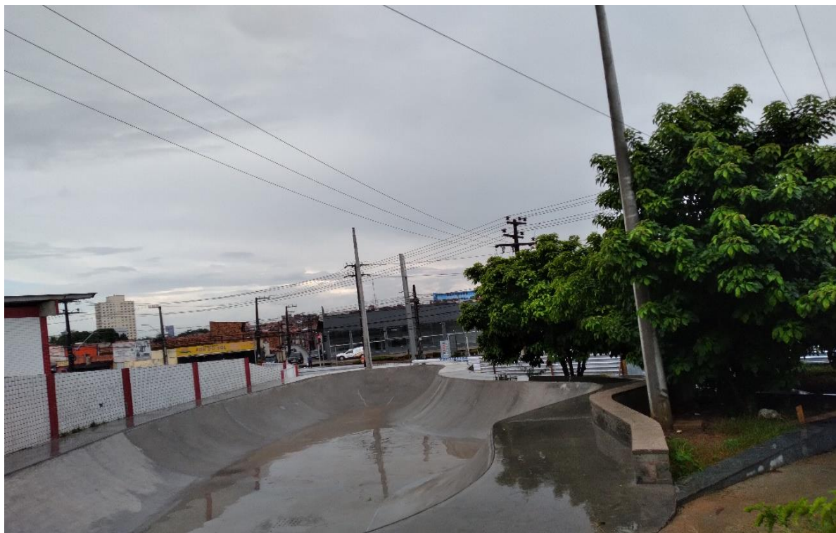
Vista da nova pista do Skate Park , construída durante o período em que a obra foi retomada – entre agosto e novembro de 2021 –, mas com obra ainda não concluída. São Luís, 01.03.2022.
