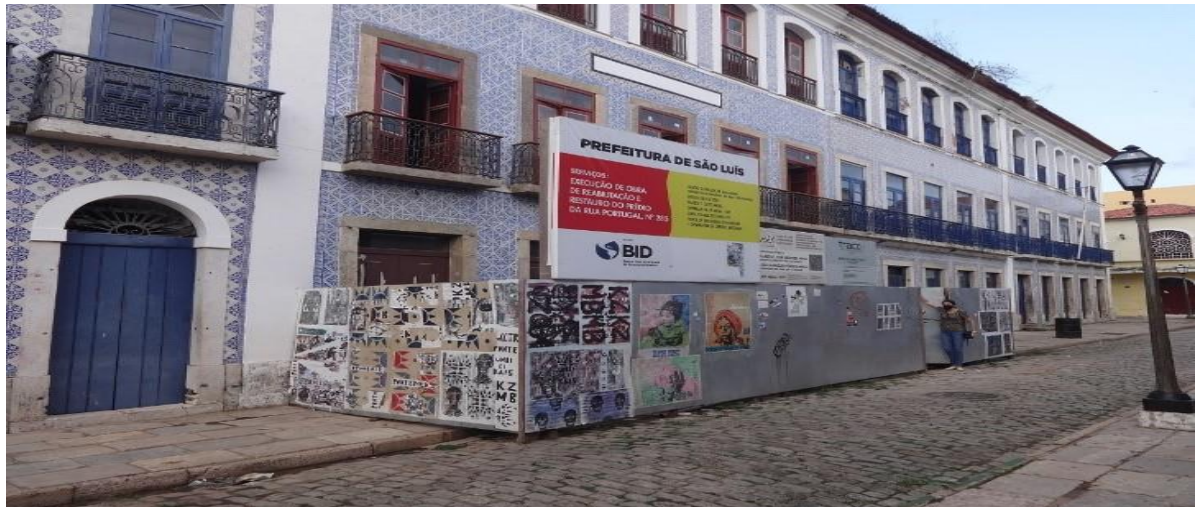
Fachada do prédio em obras. São Luís, 25.11.2020.
