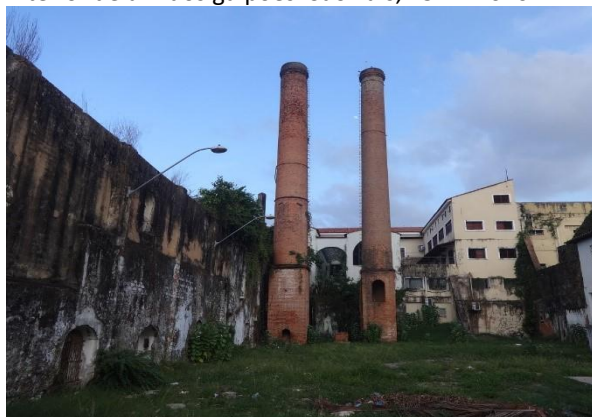
Chaminés do antigo complexo industrial. São Luís, 25.11.2020.
