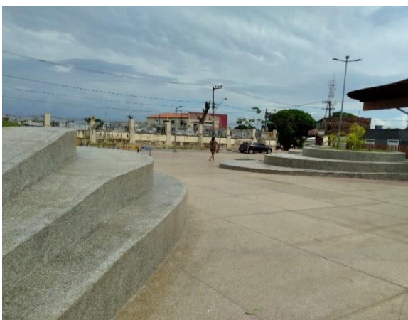
Obra já concluída na Praça da Saudade. São Luís, 08.07.2021.
