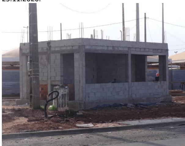
Um dos quiosques em construção no entorno da praça da Fonte do Bispo. São Luís, 25.11.2020.
