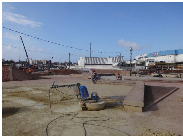
Trecho da praça em construção na Fonte do Bispo, com funcionários da obra em destaque. São Luís, 25.11.2020.
