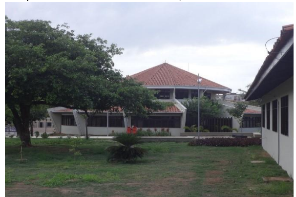
Prédio administrativo do Parque do Bom Menino. São Luís, 25.11.2020.
