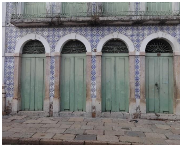
Térreo do prédio da Rua Portugal, nº 251. São Luís, 25.11.2020.
