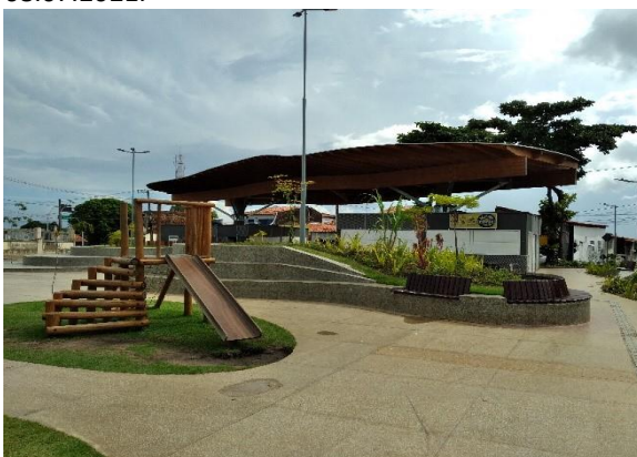
Vista de parte da Praça da Saudade, com a obra já concluída. São Luís, 08.07.2021.
