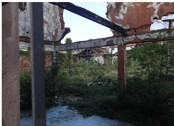
Interior de um dos galpões. São Luís, 25.11.2020.
