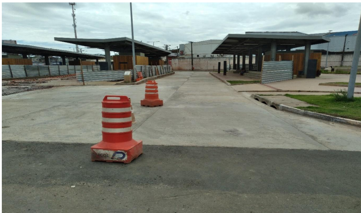
Pista da direita interditada com piso em pavimento rígido de concreto armado. São Luís, 29.06.2022.
