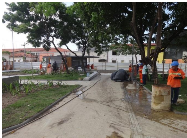
Trecho ainda em obras da Praça da Misericórdia. São Luís, 25.11.2020.
