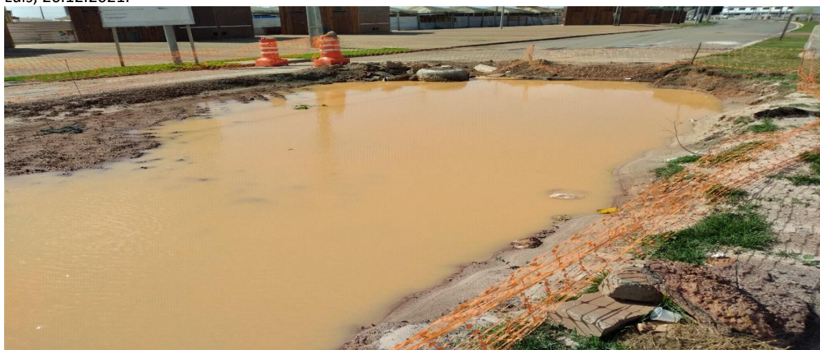
Área interditada para execução de obras de drenagem, junto aos quiosques construídos e não inaugurados. São Luís, 16.01.2022.
