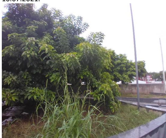
Vegetação abundante na obra do Skate Park, que ainda não havia sido concluída. São Luís, 01.03.2022.
