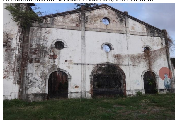
Ruínas de edificação. São Luís, 25.11.2020.
