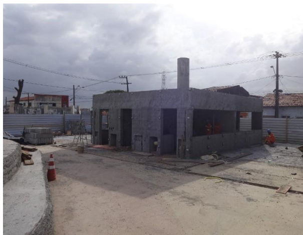
Construção para abrigar os quiosques da Praça da Saúde. São Luís, 25.11.2020.
