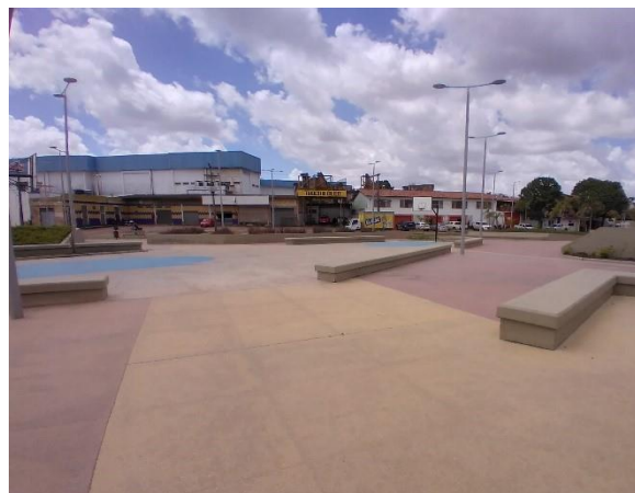
Mesmo trecho, após o término da obra. São Luís, 10.07.2021.
